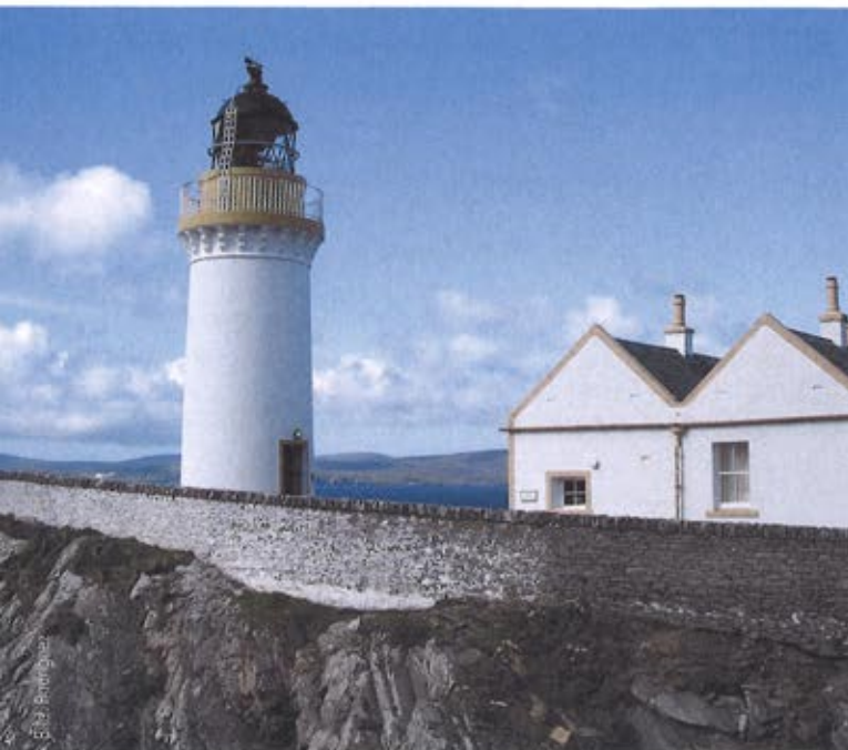
Bei der Sanierung eines Leuchtturmscheinwerfers auf der Shetlandinsel Bressay fiel die Wahl auf ein Hochleistungs-Vierpunktlager von Rodriguez
